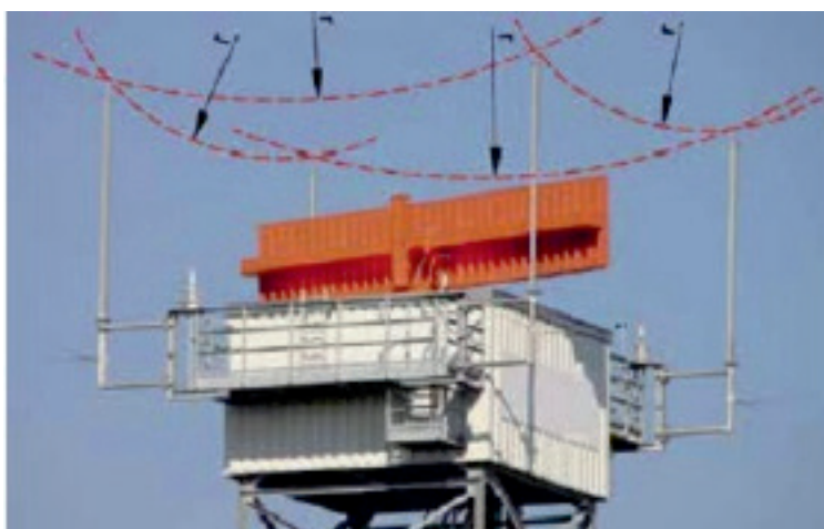
Рисунок 9. Пример использования метода фиктивной сферы.
