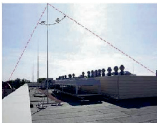
Рисунок 11. Принцип расчёта зон защиты методом защитного угла.
